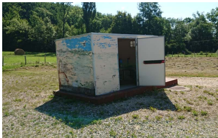
Ouvrage de protection du forage
